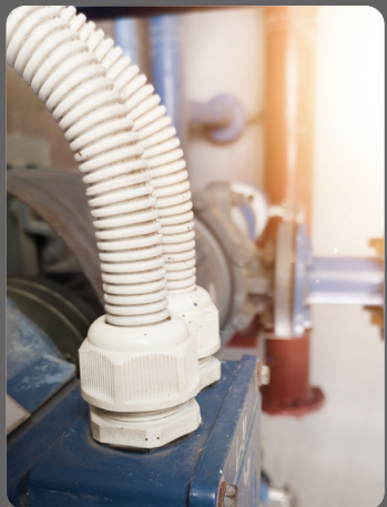
Сальники зажимают кабель, исключая его выдергивание.
