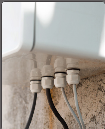
Увеличивают срок службы как самого кабеля, так и всей электрической сборки за счет защиты от вибраций.
